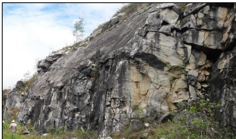
Figura 16. Grande ruptura planar afetando o talude NE1.
